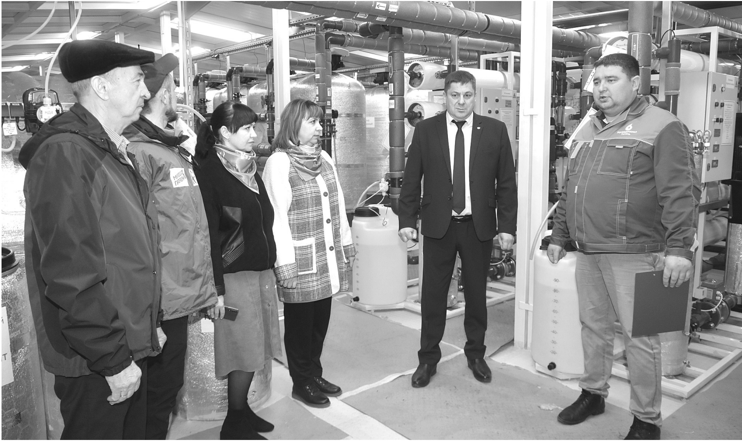
О работе станции водоочистки рассказал начальник цеха Алексей Волюнкин
