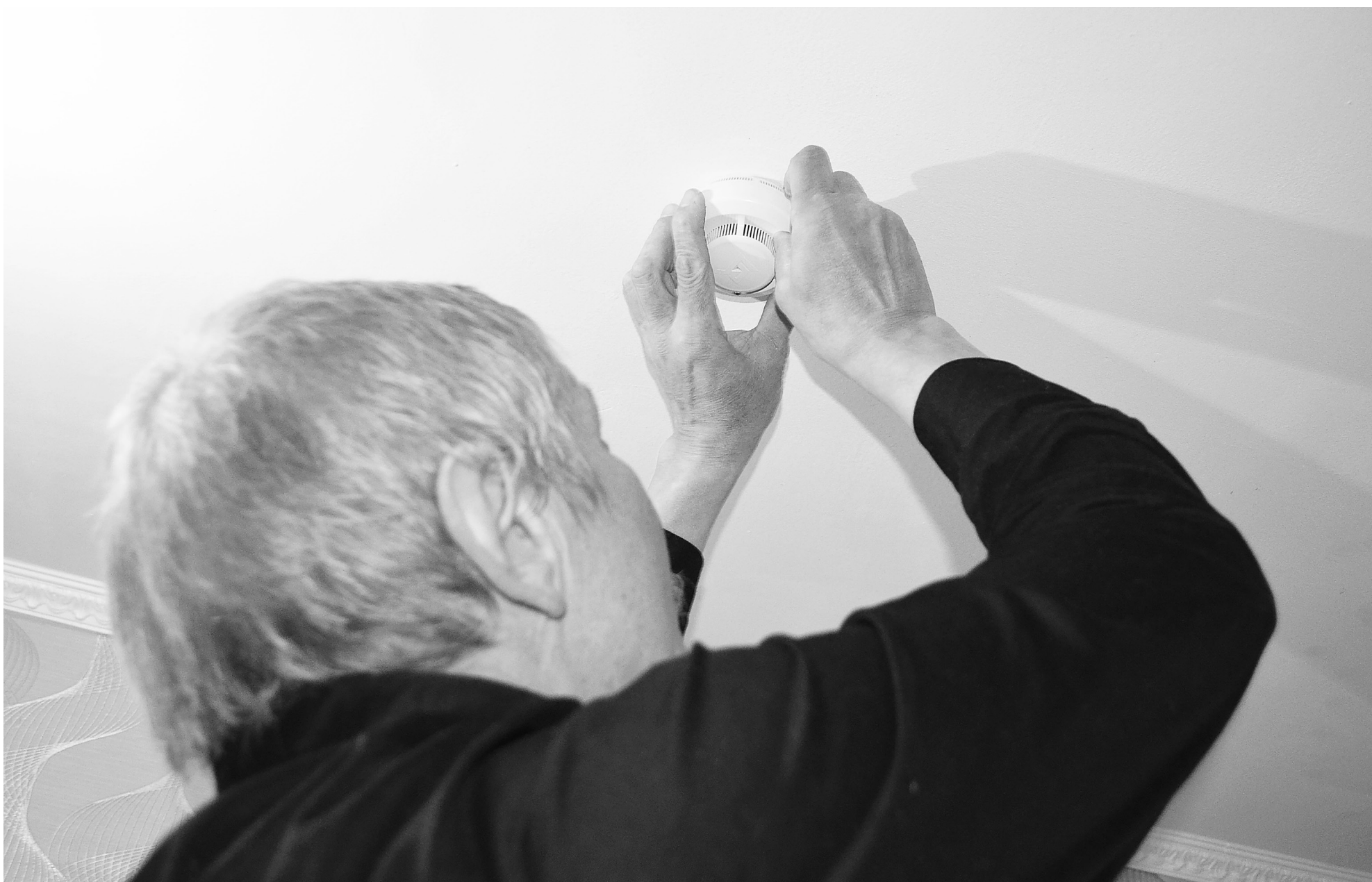
Мастер на все руки Василий Рукавишников в считанные мгновения устанавливает дымовой пожарный извещатель под потолок.
