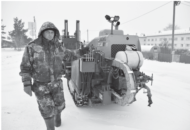
В Гилево будет отремонтировано 2,3 километра сетей теплоснабжения
