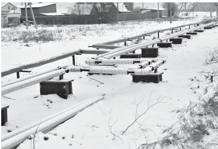
Часть труб будет проложена по поверхности, часть уйдет под землю
