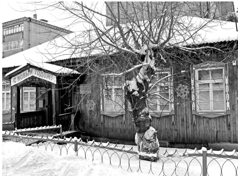
• С начала 1960-х годов в этом доме на улице Сибирской в городе размещались сначала библиотека, потом станция скорой помощи. А с 1994 по 2020 год здесь был Заводоуковский краеведческий музей.
