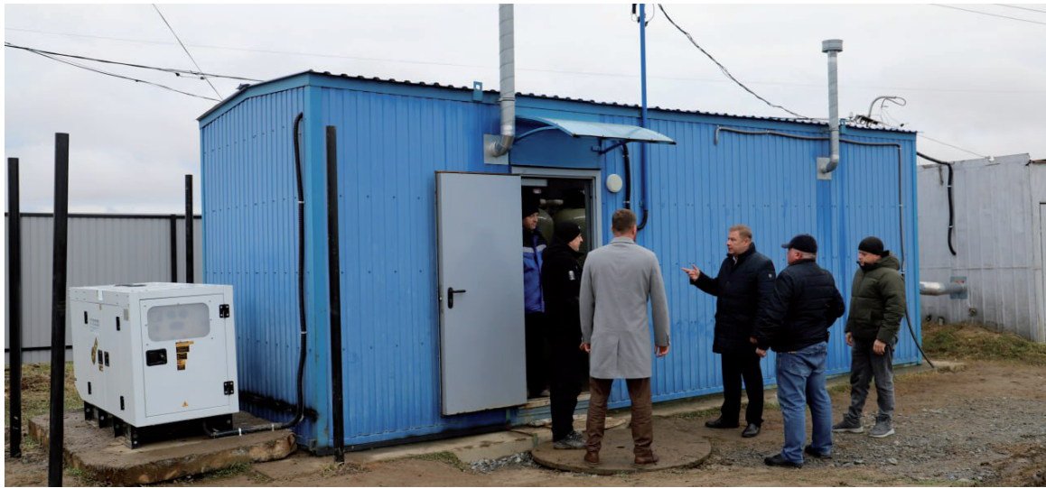
На станции водоочистки в Ивановке проведена модернизация.
