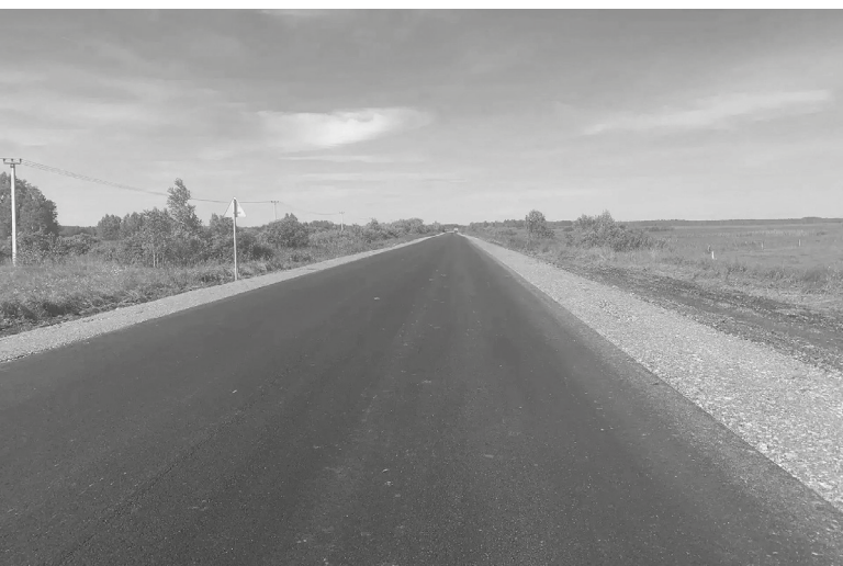
■ На снимках: Двухслойное асфальтобетонное покрытие уложено на участке дороги в Сорокинском округе. Работы стартовали 24 апреля, завершение — в августе/ ФОТО: АРХИВ
