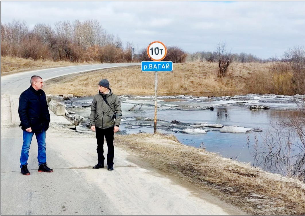
• Мост у деревни Новоуфимской подготовлен к прохождению паводка. ► Фото администрации округа.
