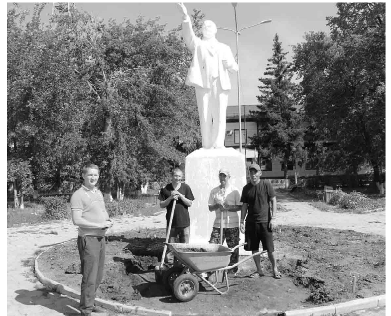
Предприниматель Владимир Стрельцов контролирует ход ремонтных работ памятника Ленину
