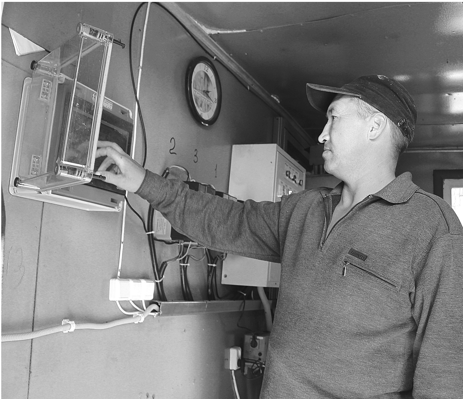
Следить за работой зерносушильного комплекса рабочему СПК «Артур» Евгению Трифонову помогает современное компьютерное оборудование
