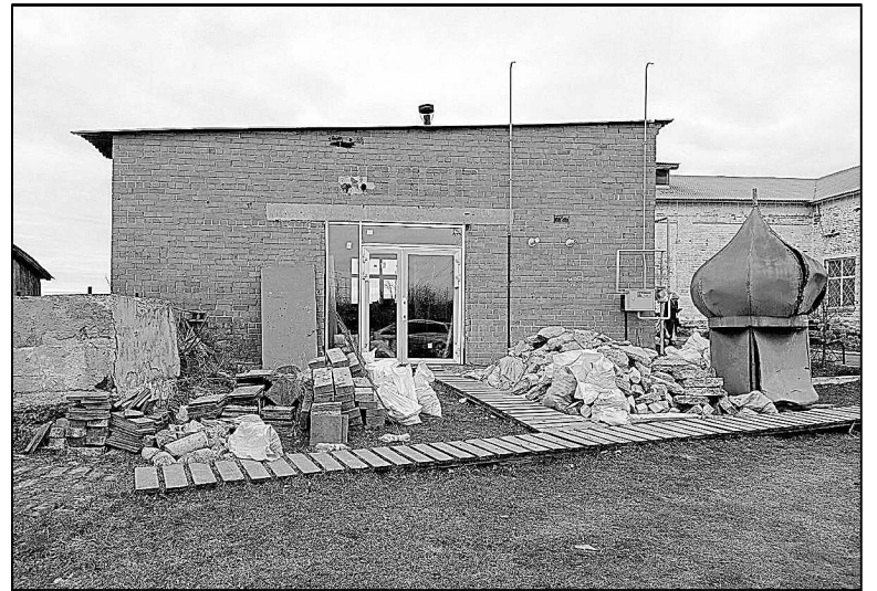
Работы по обустройству трапезной идут полным ходом.
