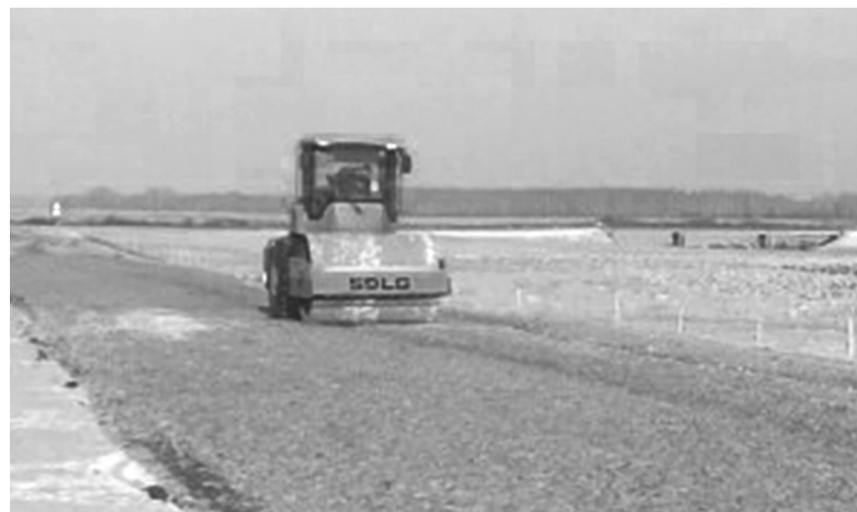
Повреждённый отрезок автодороги Тюмень — Ишим — Омск — Голышманово — Шулындино начали восстанавливать — производится отсыпка щебнем
