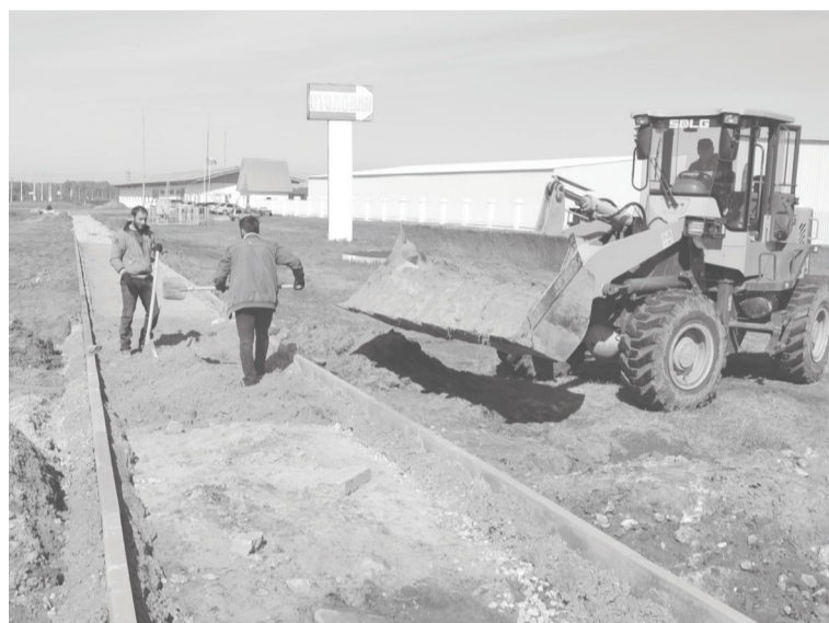
Завершается укладка тротуара в с. Бызово.
