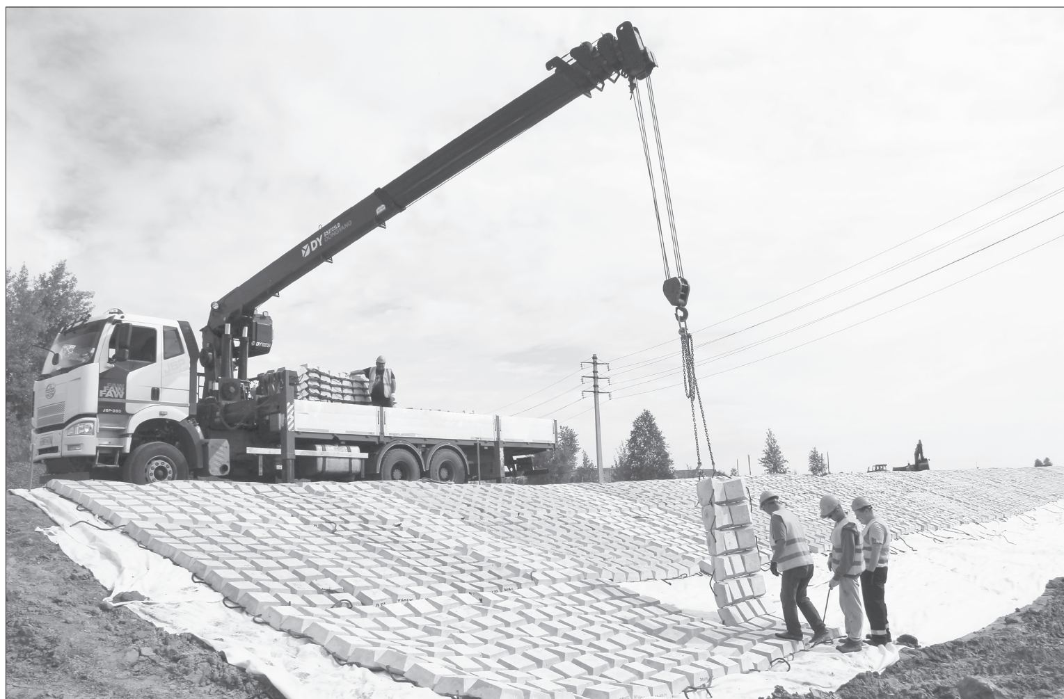
Сборные гибкие конструкции с наполнителем пришли на замену применявшимся в прошлом цельным бетонным плитам
