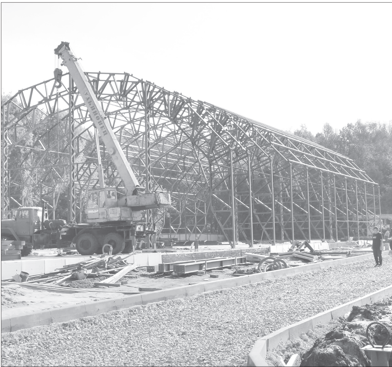
Одновременно с монтажом каркаса частично обустривают территорию /ФОТО АВТОРА
