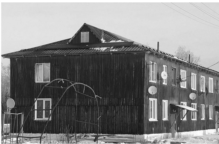
После ремонта дома в п. Нефтянике преобразятся
