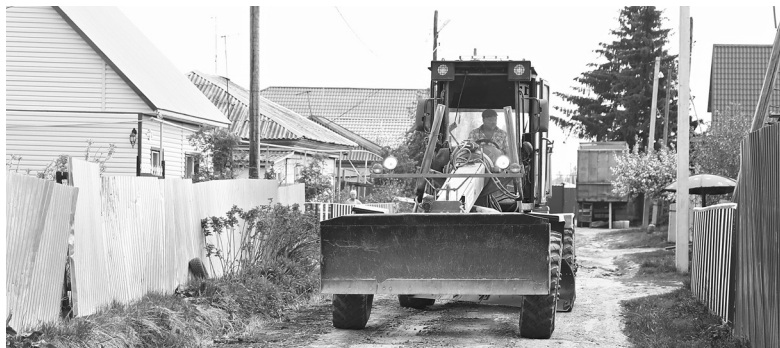
Идёт подготовка основания дороги под укладку железобетонных плит в переулке Космонавтов посёлка Голышманово
