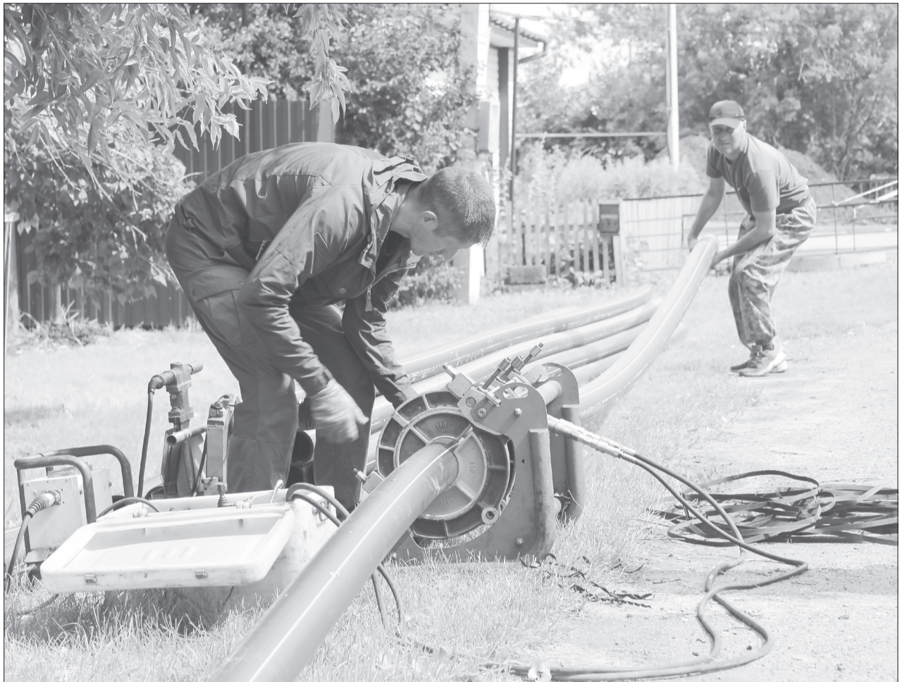
Современные пластиковые трубы припаивают друг к другу перед протяжкой под землёй /ФОТО АВТОРА
