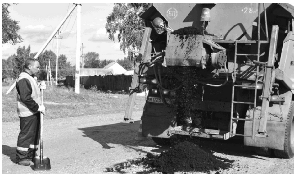
На снимке: ямочный ремонт асфальтового покрытия – один из способов поддержания дорог в рабочем состоянии
