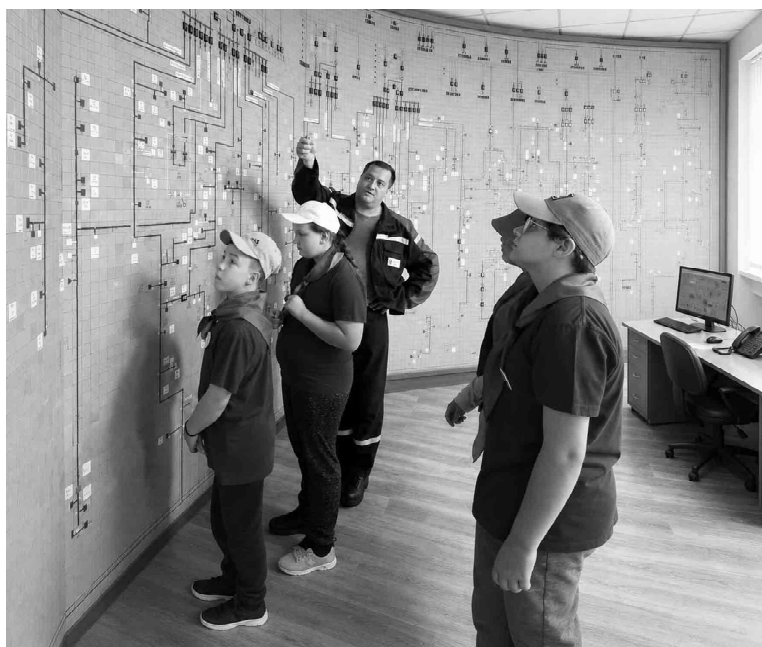
Во время экскурсии в РЭС подростки узнали, как обеспечивается электроснабжение округа
