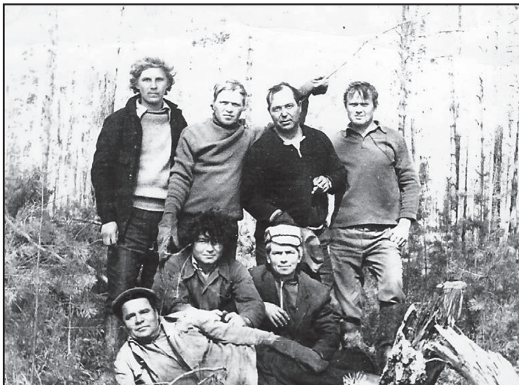
На строительстве линии телефонной связи (В.Ф. Быков стоит справа)
