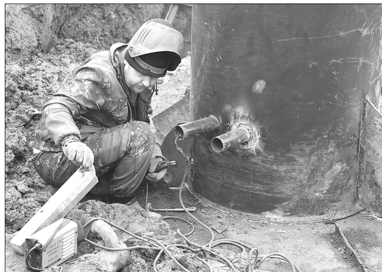
Сварщик Сергей Колосов приваривает трубу, чтобы надёжно держала массивное сооружение
