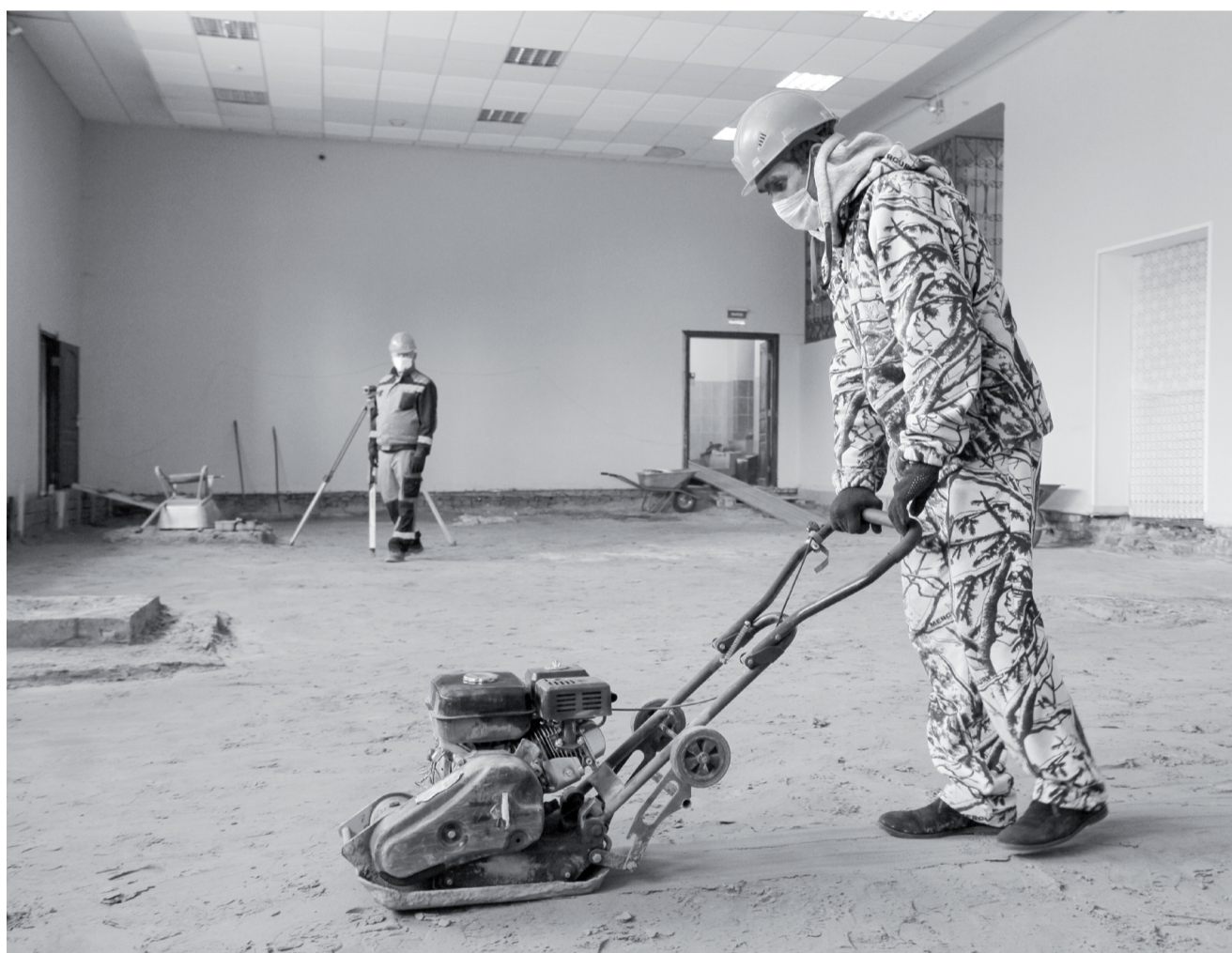
В Концертном зале им. 30-летия ВЛКСМ кипят ремонтные работы: приведя в порядок кровлю, строители перешли к замене напольного покрытия. // Фото Василия БАРАНОВА.
