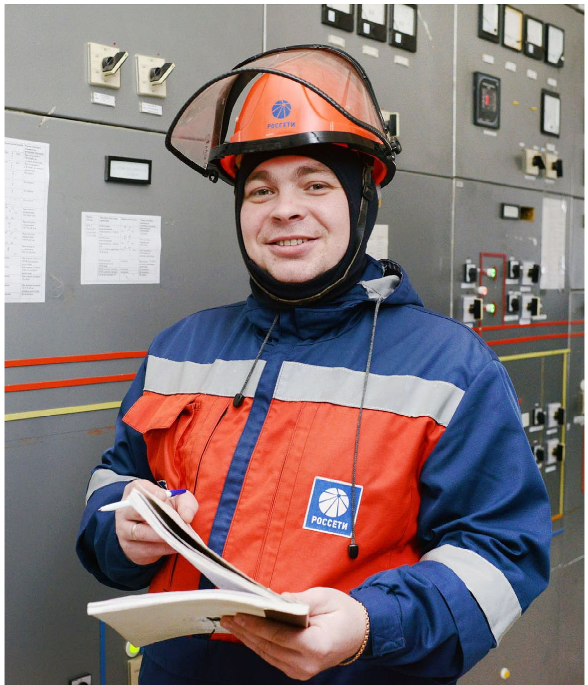
Егор Молодых проводит утренний обход подстанции
