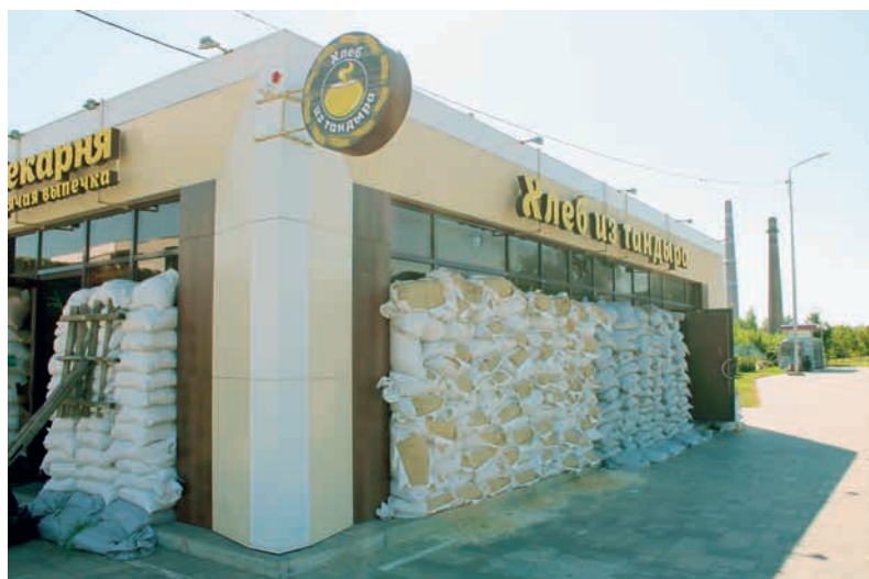
Шебекино. Магазины, остановки, другие учреждения обложены мешками с песком во избежание осколочных ранений людей
