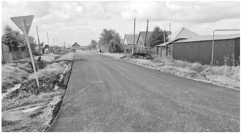
Долгожданный асфальт уложили на улице Дорожной. На очереди – съезды к домам
