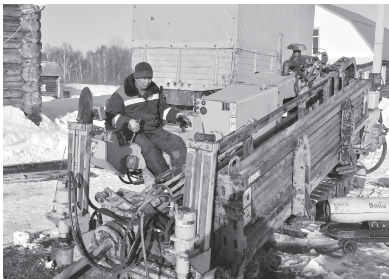
Газовая магистраль в Молодежном прокладывается закрытым способом, с помощью установки «Навигатор»
