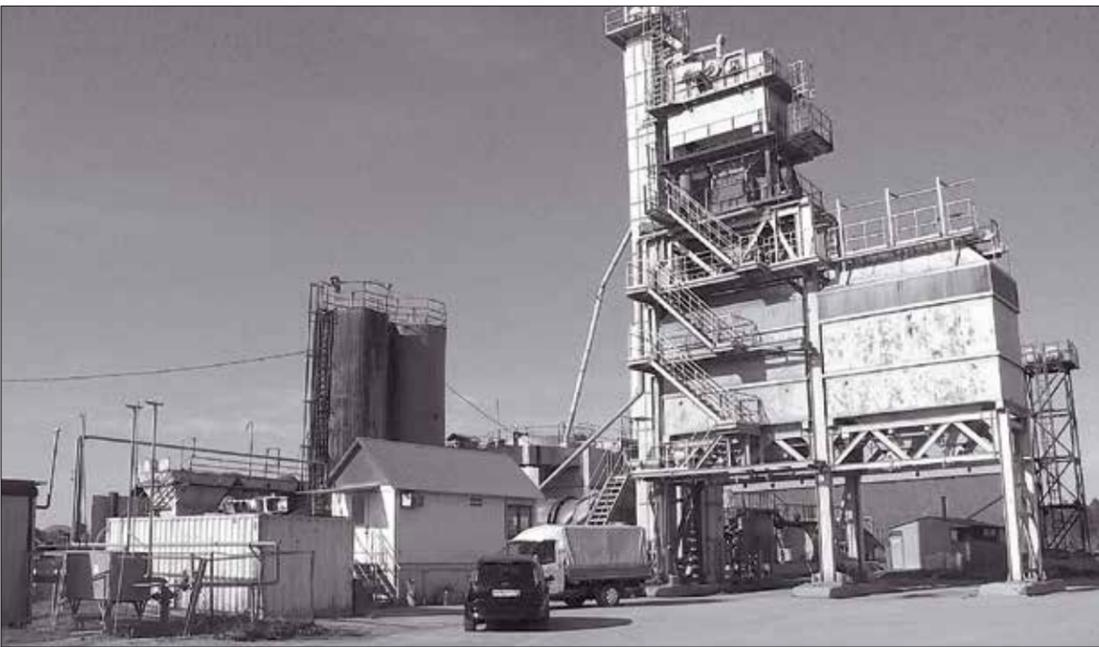
После модернизации АБЗ начал выпуск нового материала – щебёночно-мастичного асфальтобетона
