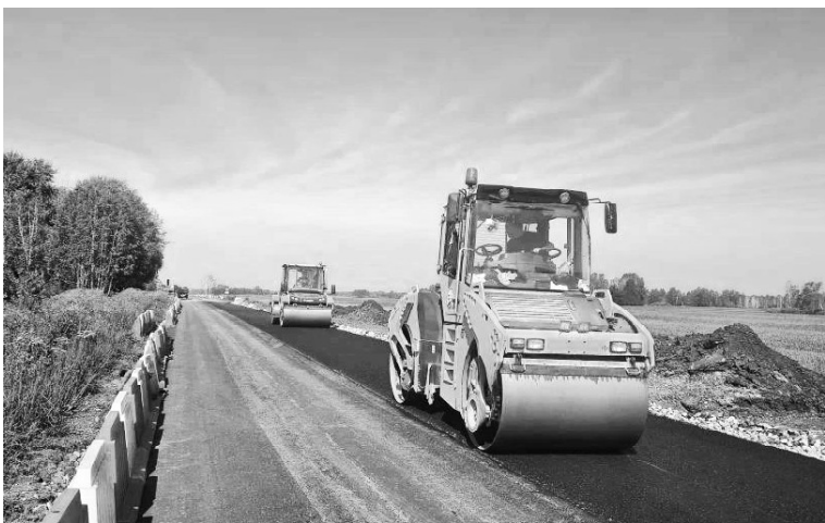
➤ Ремонт дороги на участке Викулово-Озерное-Катай // Фото с сайта Главного управления строительства ТО
