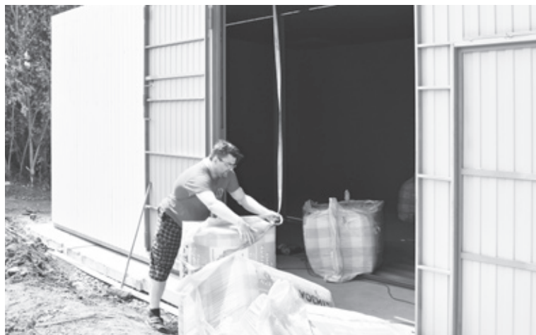
На будущей станции водоочистки проводятся работы по утеплению строения. Фото автора
