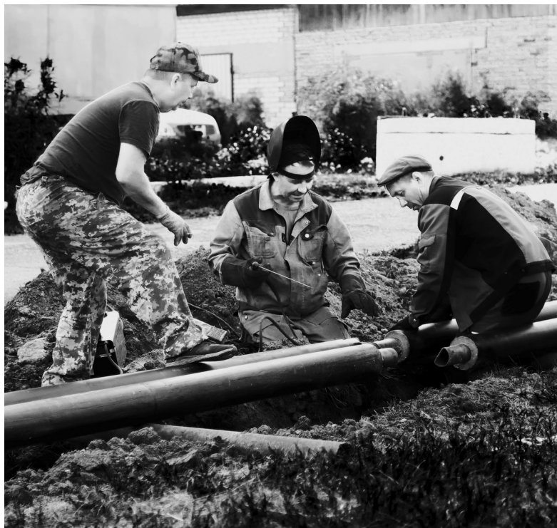
Работники коммунальной службы меняют теплосети у дома № 35 на улице Ленина в посёлке Голышманово
