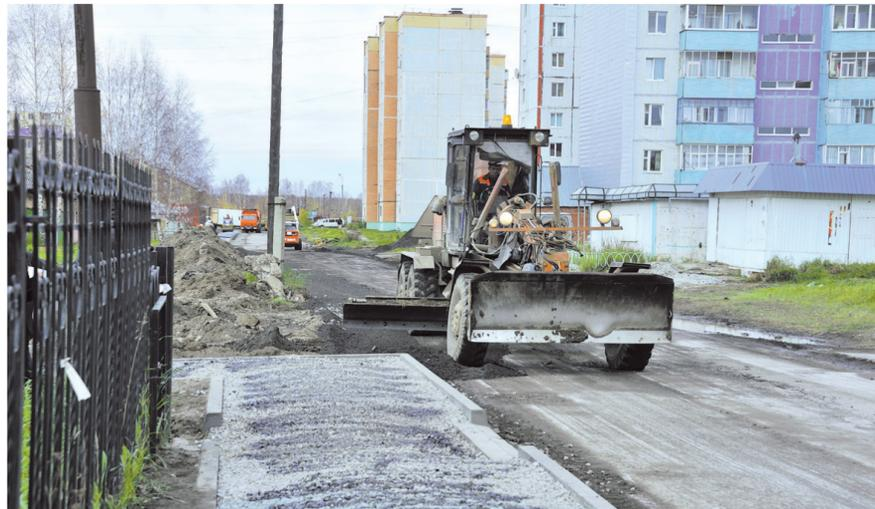
26 сентября. За этот период удалось выполнить большой объём запланированных работ: снятие дорожного покрытия, уширение дорожной части, замену бордюров, устройство 360 метров тротуара.
