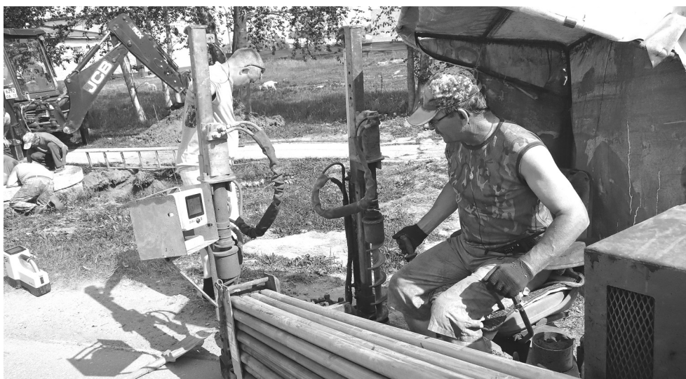
Навигаторщик Виктор Бехтерев с коллегами прокладывает водопровод к молодёжному центру на улице Садовой. При подготовке к зиме коммунальщики отремонтируют около пяти километров водопроводных сетей
