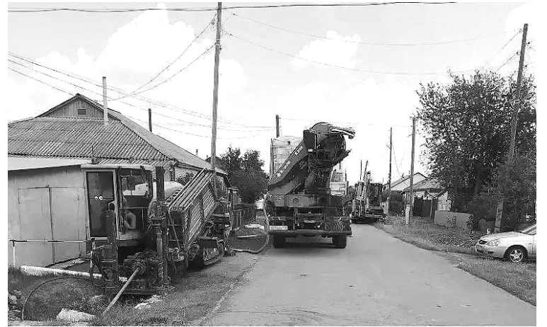
Прокладка новой водопроводной линии. Временная линия позволяет вести работы без отключения воды для жителей. / ФОТО АРХИВ
