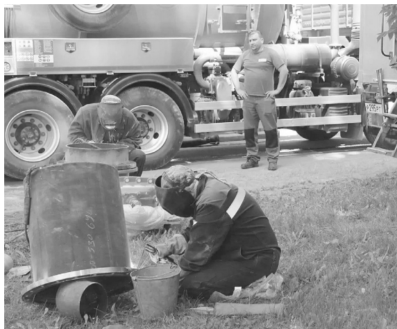
В населенных пунктах Бердюжского округа ведутся работы по улучшению водоснабжения
