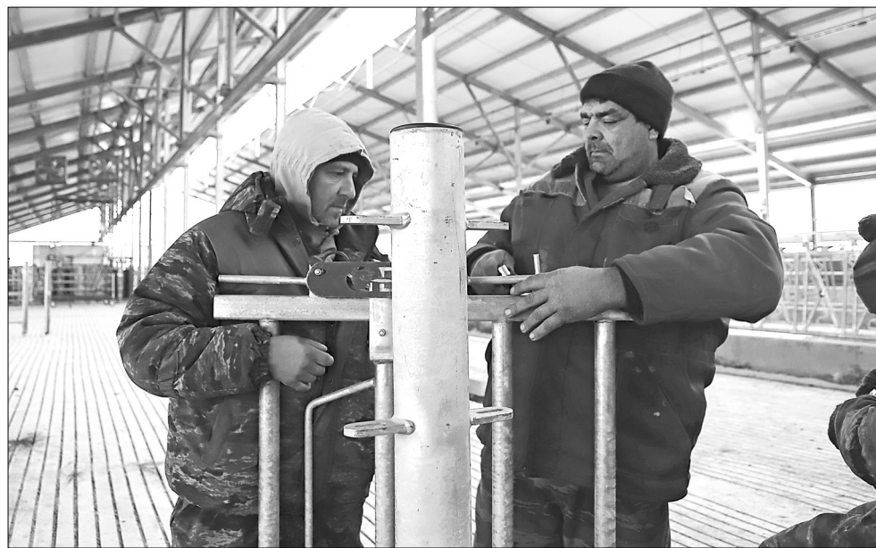
Установка стойлового оборудования
