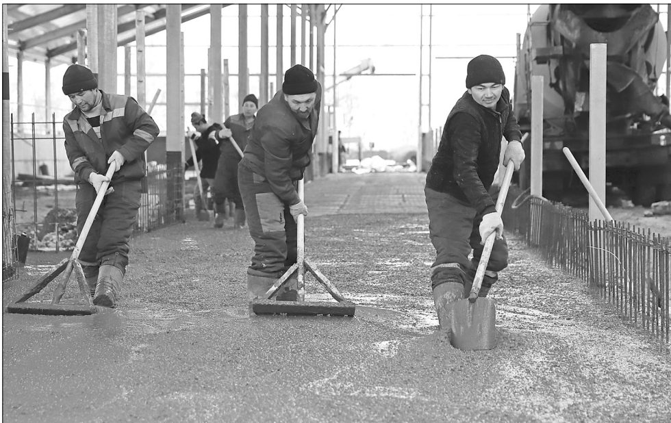
Рабочие заливают подход к кормовому столу
