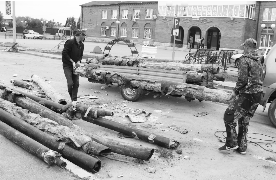
Рабочие грузят старые трубы. По соседству заканчивается уборка строительного му- сора. Ещё один рабочий разравнивает гравий на территории школы. Одним словом, благоустройство территории, где была заменена теплотрасса, идёт полным ходом.
