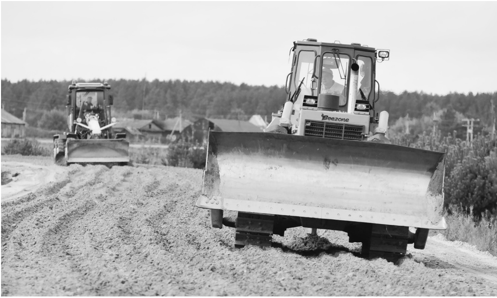
Бригада бульдозеристов рыхлителями, которые внешне напоминают плуг, перемещивает щебень с песком. Эта технология хорошо зарекомендовала себя на многих дорогах нашего района.
