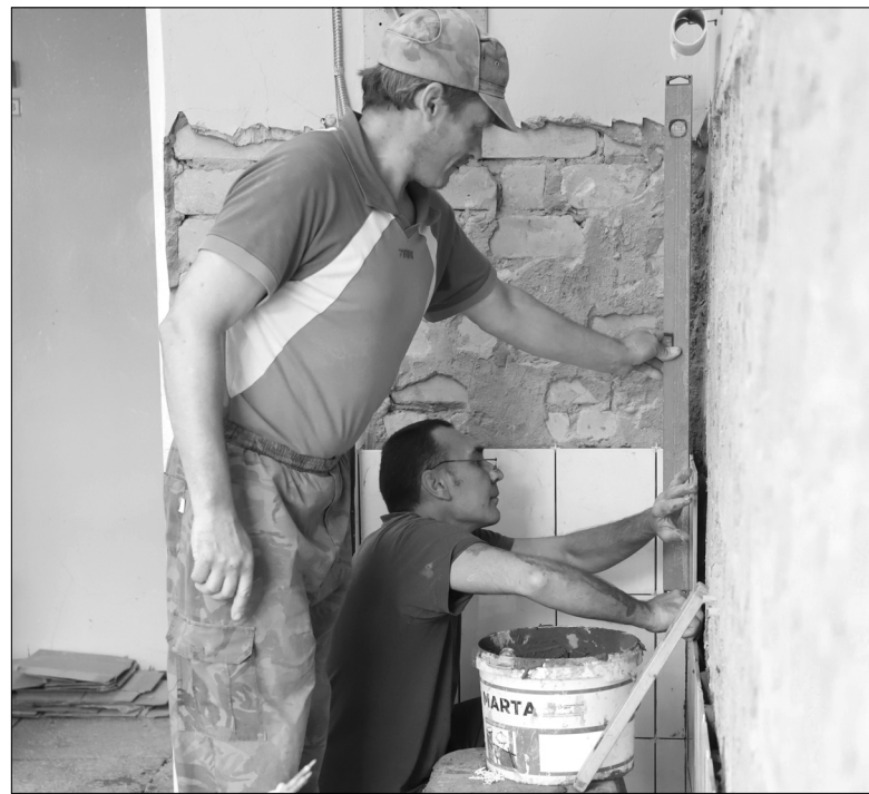
Пищеблок Голышмановской сельской школы после ремонта засияет новой плиткой
