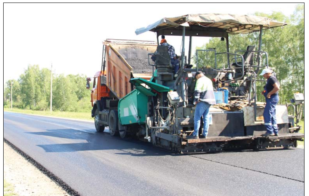
• Ремонтируя областную трассу, дорожники не считают её временной.
