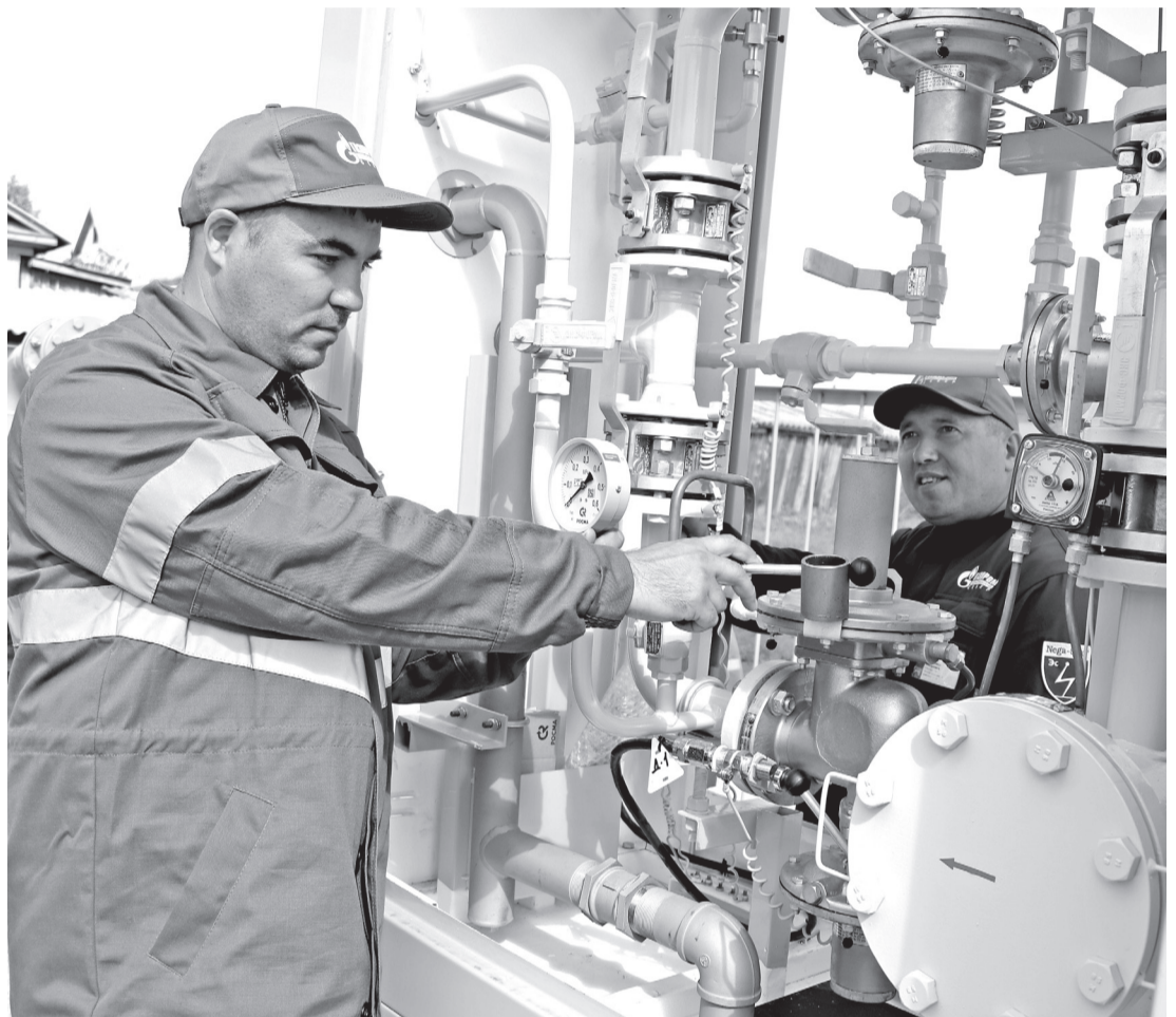
• Сергей Кузюбердин (слева) и Александр Макаров, слесари по эксплуатации и ремонту газового оборудования АО «Газпром газораспределение Север», провели запуск нового газопровода в деревне Пономарёвой.
