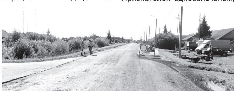
Ведётся поэтапный ремонт дороги по ул. Восточной районного центра
