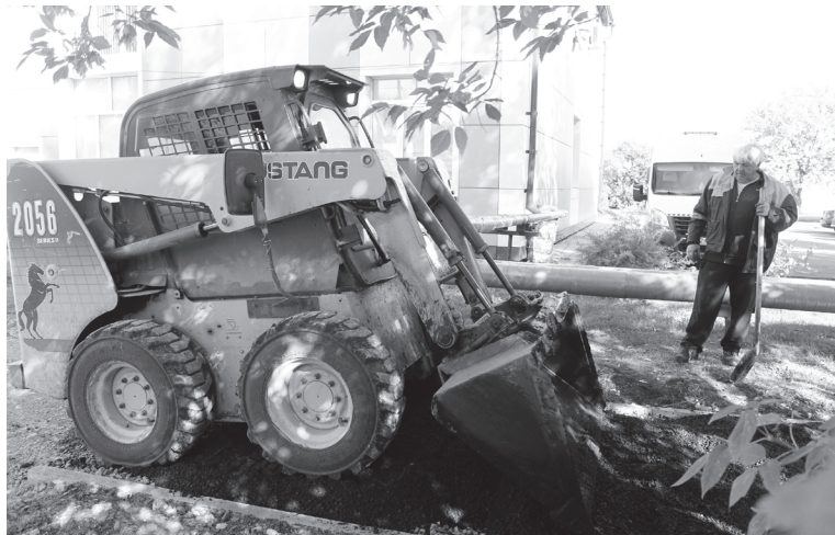
Идёт обустройство контейнерной площадки
