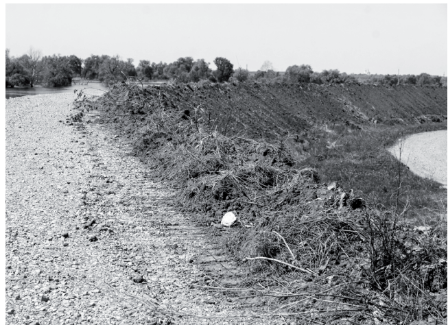
Участок за участком дамбы приводят в нормативное состояние, поднимая в высоту до 11,3 метра, чтобы не страшен был никакой паводок. // Фото автора.
