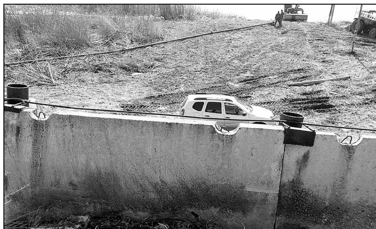
Отметка на защитном сооружении в Ембаево: «12.05.2016. 8.68». В тот год уровень Туры поднялся до 868 см.
