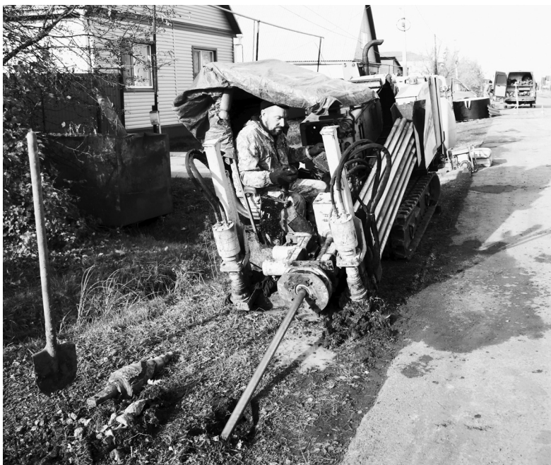
Работники «Росводоканал Тюмень» ремонтируют водопроводные сети на улице Тюменской в посёлке Голышманово
