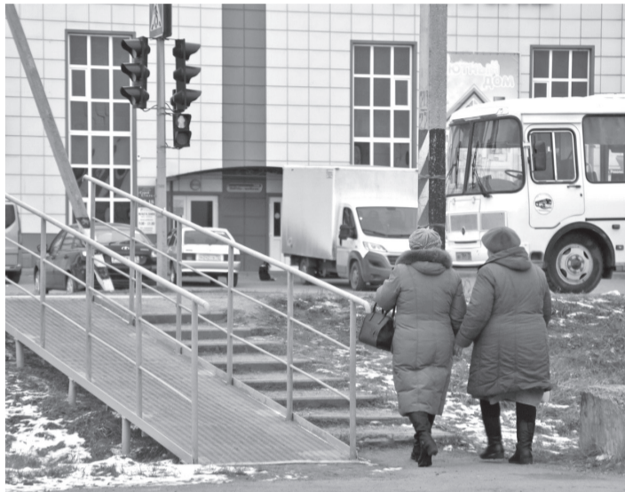
• Подрядчик в Заводоуковске не только отремонтировал автобусные остановки, но и сделал удобные переходы-пандусы от проезжей части к кафе «Уют» на улице Революционной и от автозаправки Н1 к тротуару на улице Энергетиков.
