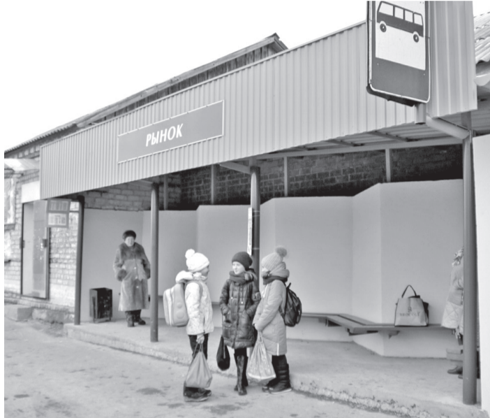
• Остановка в Заводоуковске близ городского рынка давно требовала капитального ремонта. Сегодня её не узнать.
