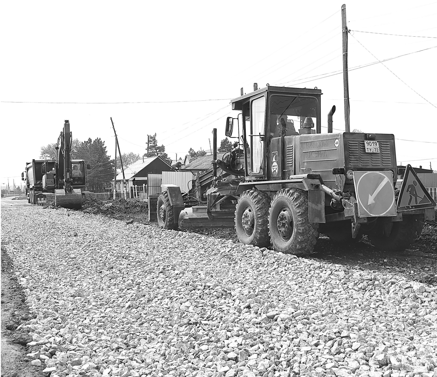
Работники ДРСУ-4 производят выборку грунта и готовят основание под укладку асфальтобетона на дороге Голышманово – Шулындино
