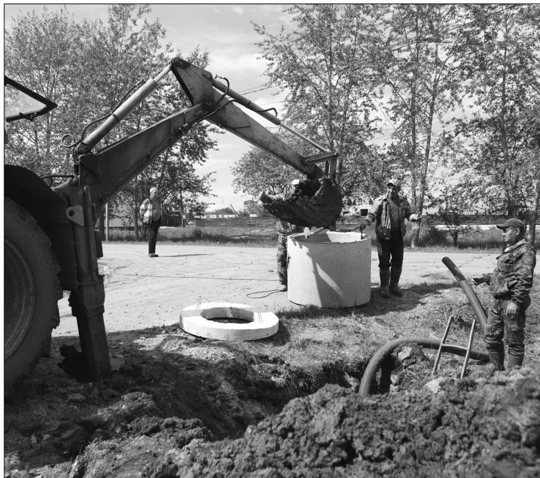
Работники ООО «Голышмановотеплоцентр» устанавливают канализационный колодец по улице Садовой посёлка
