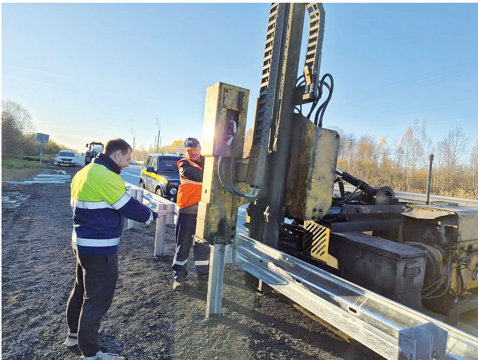
► Установка МБО (металлического барьерного ограждения)
