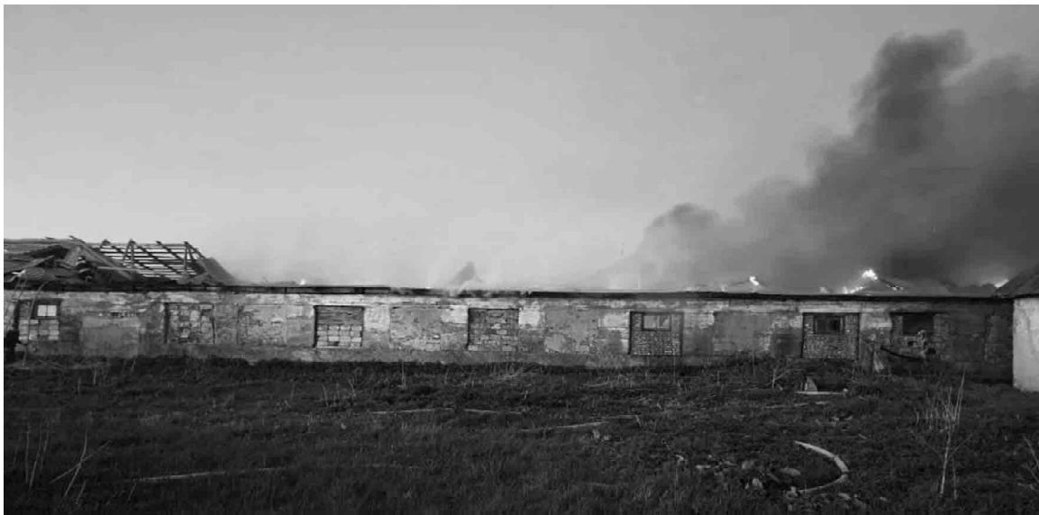
Возгорание на крыше неэксплуатируемого здания
