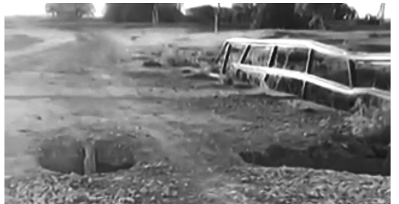
Обрушенные подъездные пути моста в деревне Большие Чирки не позволяют проехать к Ивановскому ключу
